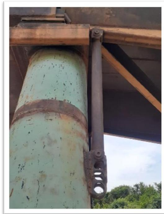
Toda la estructura se encuentra a la intemperie, afectada atmosféricamente por las lluvias y humedad del ambiente. Sin embargo, no cuenta con protección al desgaste por corrosión, es decir, no tiene ningún tipo de aislante preventivo, como pintura epoxica.
