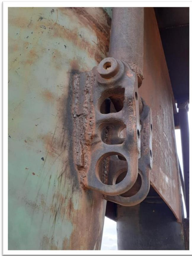
Una vez verificadas las líneas de cordón de soldadura, se observó que son de muy mala calidad. Esto significa que no se ejecutaron con el respectivo procedimiento de soldadura WPS, el cual tiene por objeto detallar qué tipo de proceso es el adecuado para determinada estructura metálica y cuantos pases de relleno se deberían realizar en cada unión de las piezas de material base.
